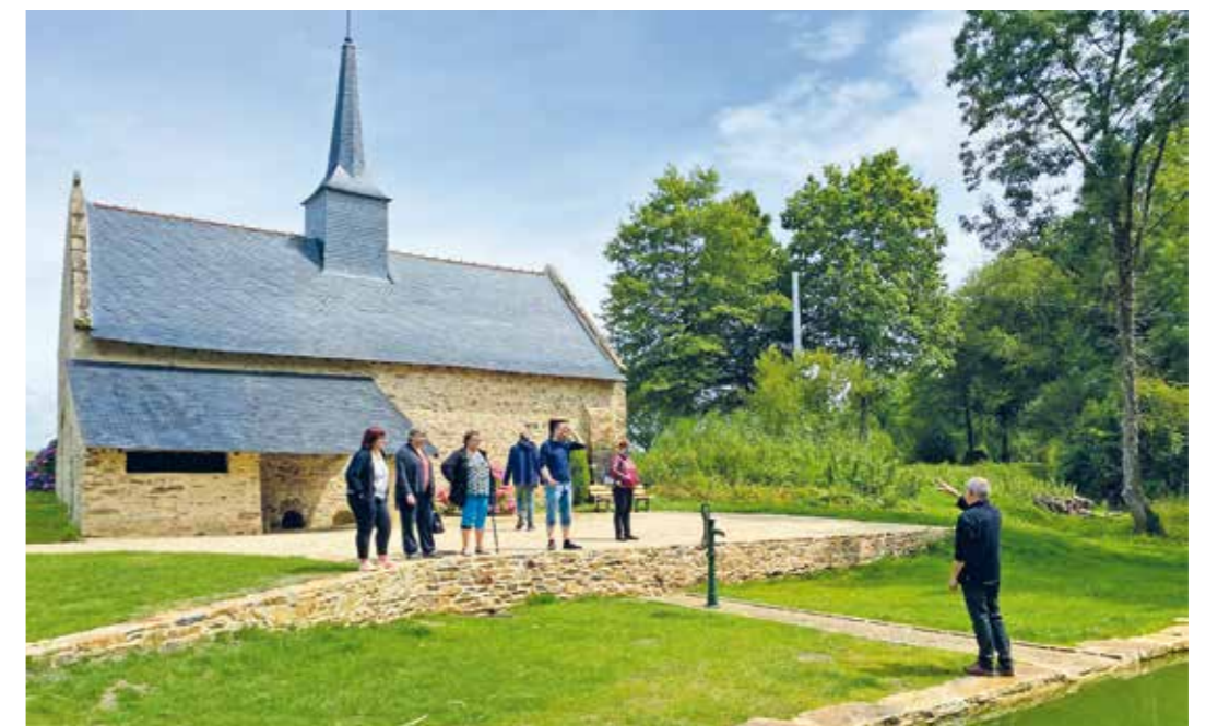
État des lieux des travaux de l'aménagement extérieur de la chapelle de Planté avec la nouvelle équipe municipale
